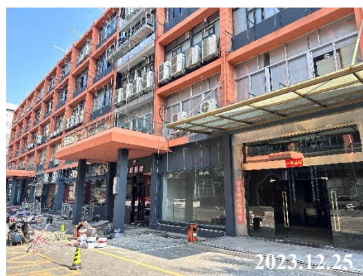
项目所在厂房建筑物外观
