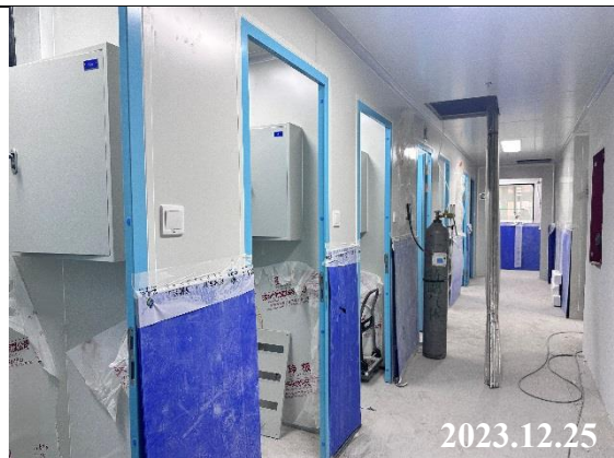
项目车间内部现状图
